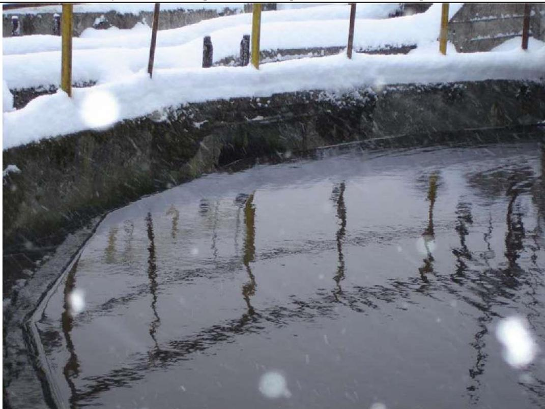
**Рисунок 24 КОС. Вторичный отстойник**
