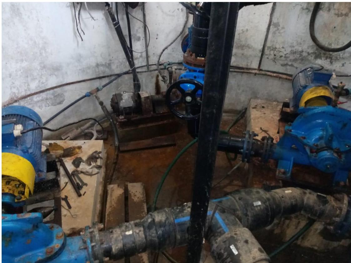
**Рисунок 8 Машинное отделение насосной станции I подъёма**
