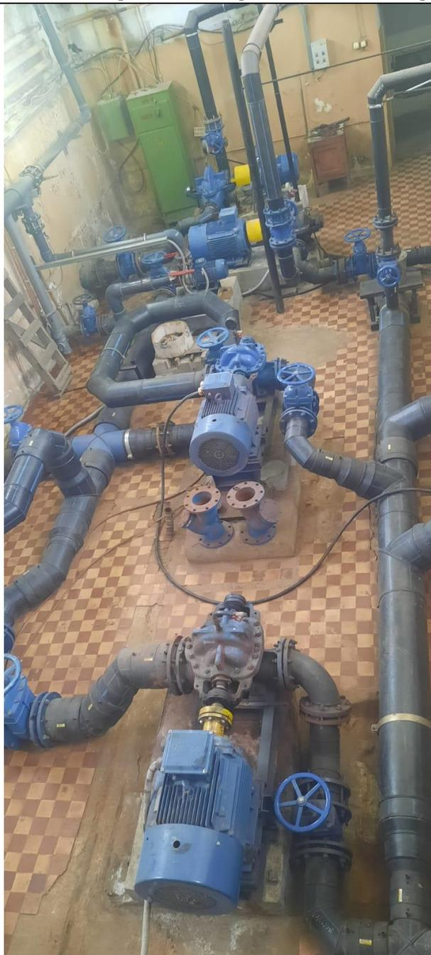
**Рисунок 9 Машинное отделение насосной станции II подъема**
