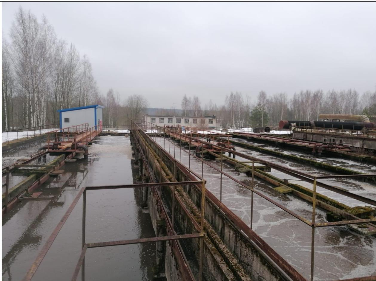
**Рисунок 26 Коридоры аэротенков**
